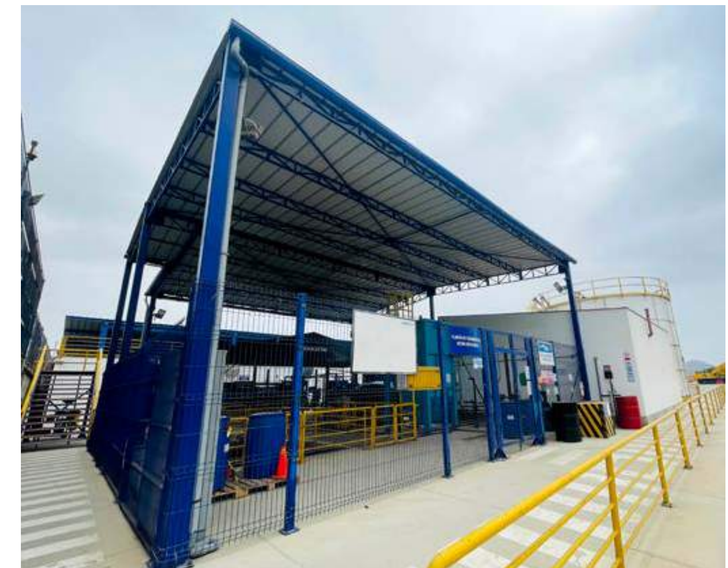
Planta de tratamiento de aguas residuales - Sucursal Pucusana
